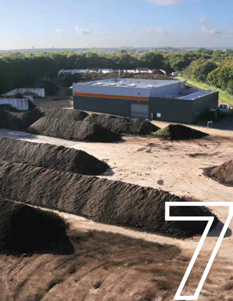
Plateforme végétaux Pleumeur-Bodou
