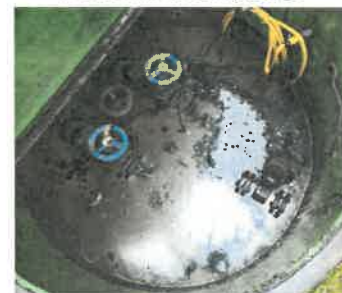
Chambre à vannes et débitmètre
